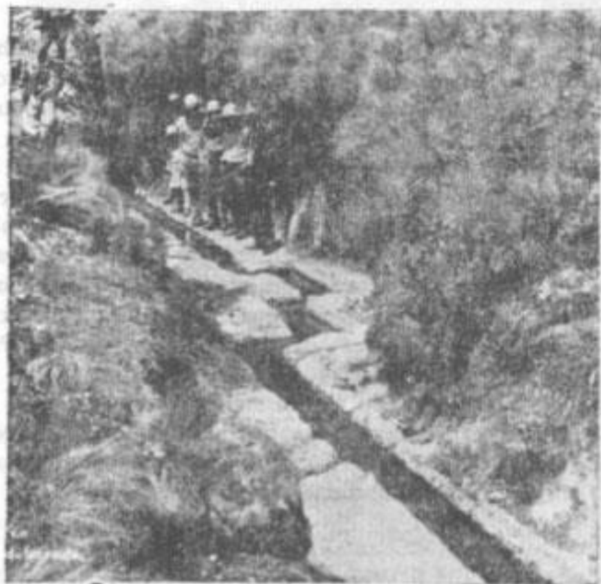
Otro detalle, a manera de signo escalonado, en la ac- quia de Kumbe Mayo.
