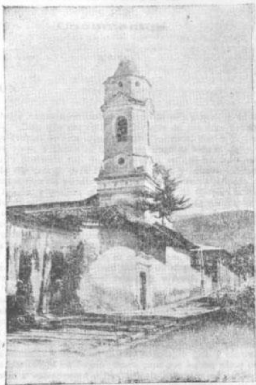
Pintoresco aspecto del monasterio e iglesia de la Concepción de Cajamarca.
